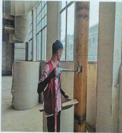
DA023 废气处理后采样口
