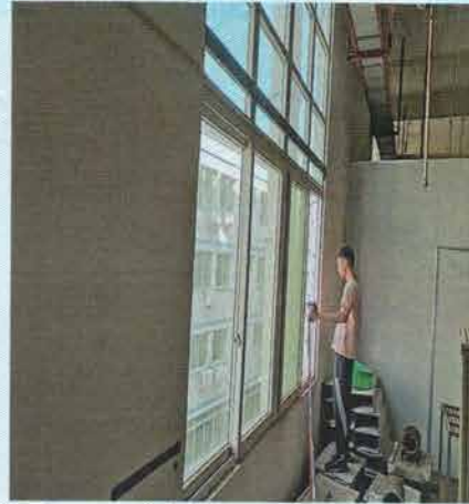
DA029 废气处理后采样口
